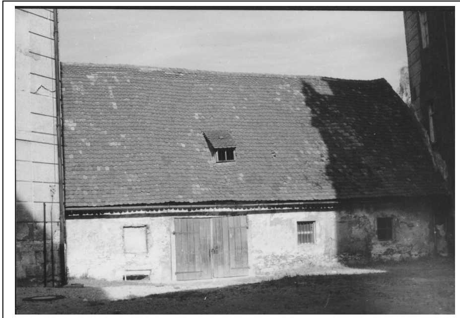
Dokumentationsfoto Stadtbauamt bei Abbruch 1960
