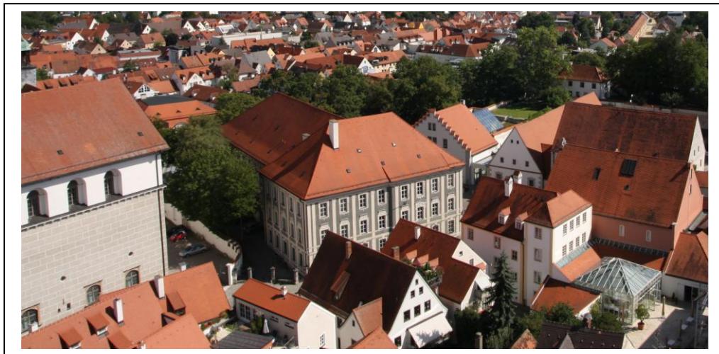
Nordostecke der Oberen Stadt mit Schloss, Amtsgericht und Marstall, sowie Häusern an der Residenzstraße
