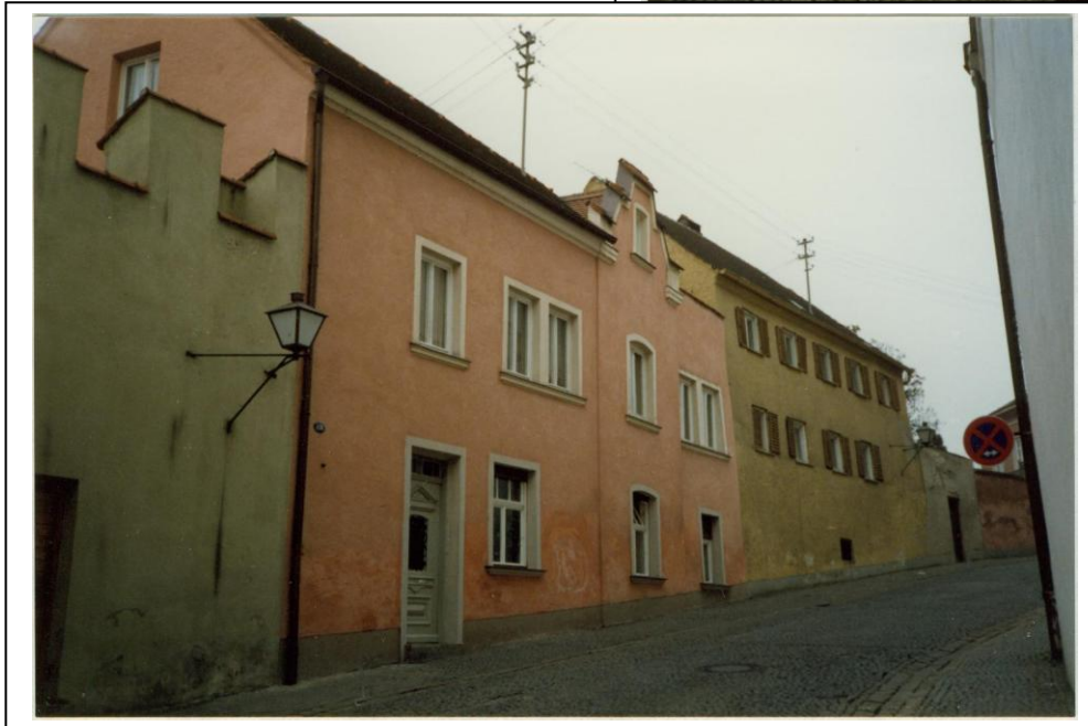
A 30 (vorne) und A 29 (weiter oben) Dokumentationsfotos Stadtbauamt bei Abbruch des Hauses A 29 im Jahr 1987
