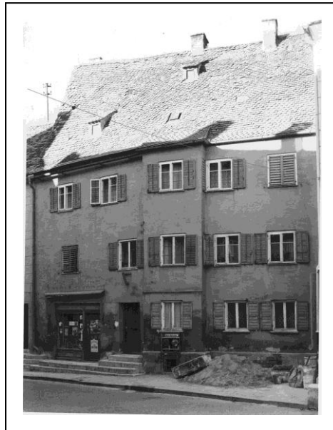
Dokumentationsfoto Stadtbauamt bei Abbruch 1962
