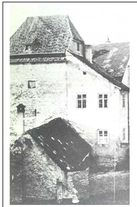
sog. Hexenturm, Westfassade, mit davor befindlichem Nebengebäude
