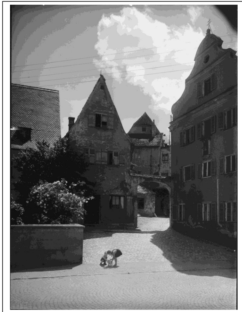
Eingang Münz mit sog. „Hexenhaus“ 1967
