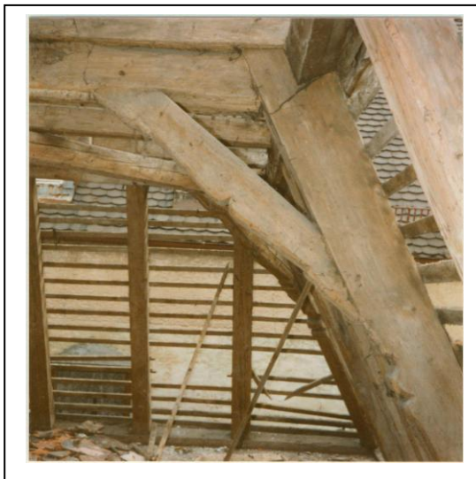
Foto-Doku Stadtbauamt bei Abbruch 1983
