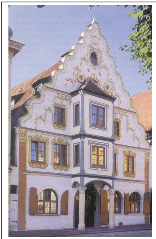
Amalienstraße A 50 nach der Sanierung 2000/2001
