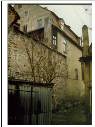
Doku-Fotos Stadtbauamt vor Abbruch der Rückgebäude A 97 im Jahr 1986
