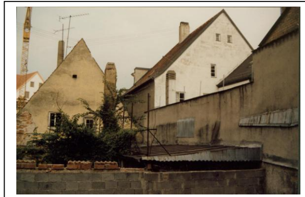
Doku-Fotos Stadtbauamt A 98 im Jahr 1986
