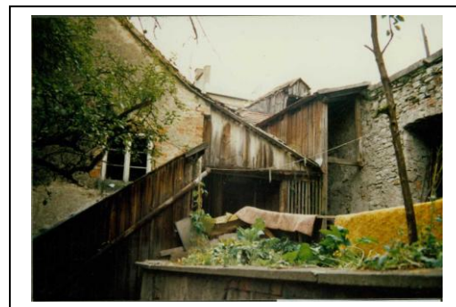
Doku-Fotos Stadtbauamt vor Abbruch der Rückgebäude A 97 im Jahr 1986
