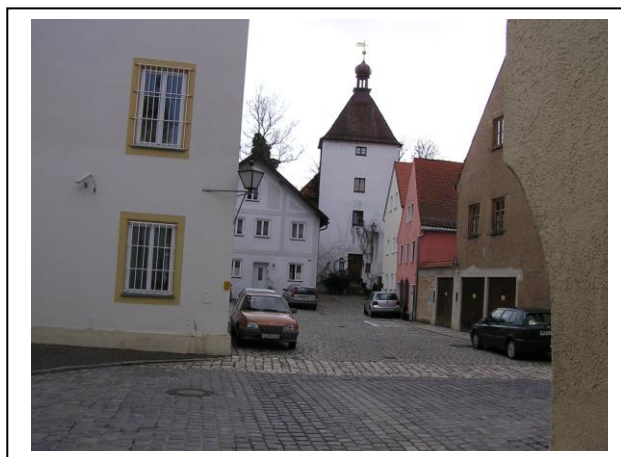
Stadtmauerturm (gehörte zur ehem. Fronveste)
