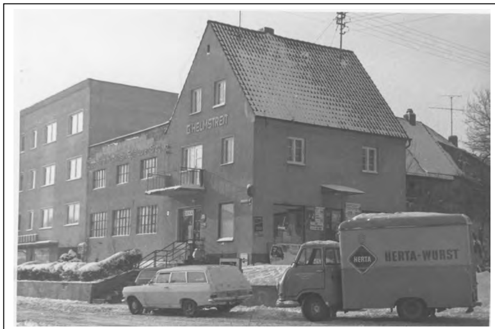
Dokumentationsfoto Stadtbauamt vor Abbruchmaßnahme 1968
