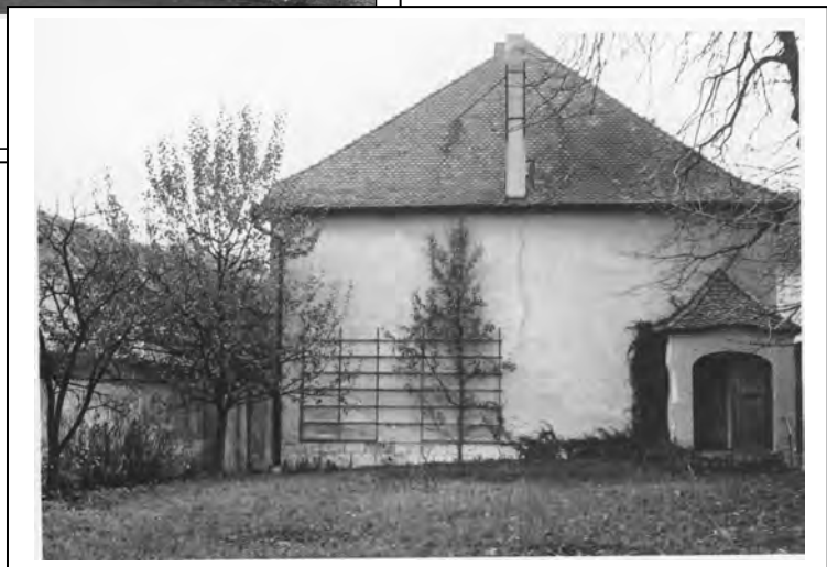
Dokumentationsfotos Stadtbauamt der Gebäude des Studienseminars vor Abbruchmaßnahmen 1967 zum Bau des neuen Gymnasiums
