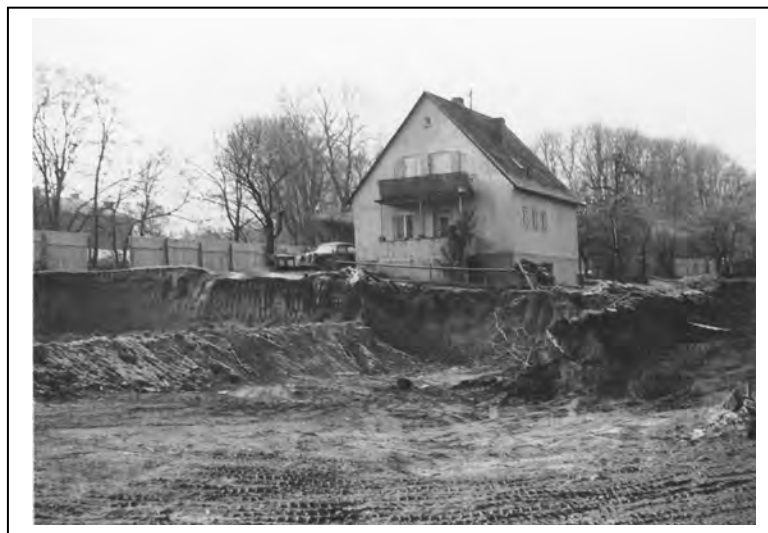
Abbruchmaßnahmen vor Bau des Gymnasiums beim Studienseminar 1967
