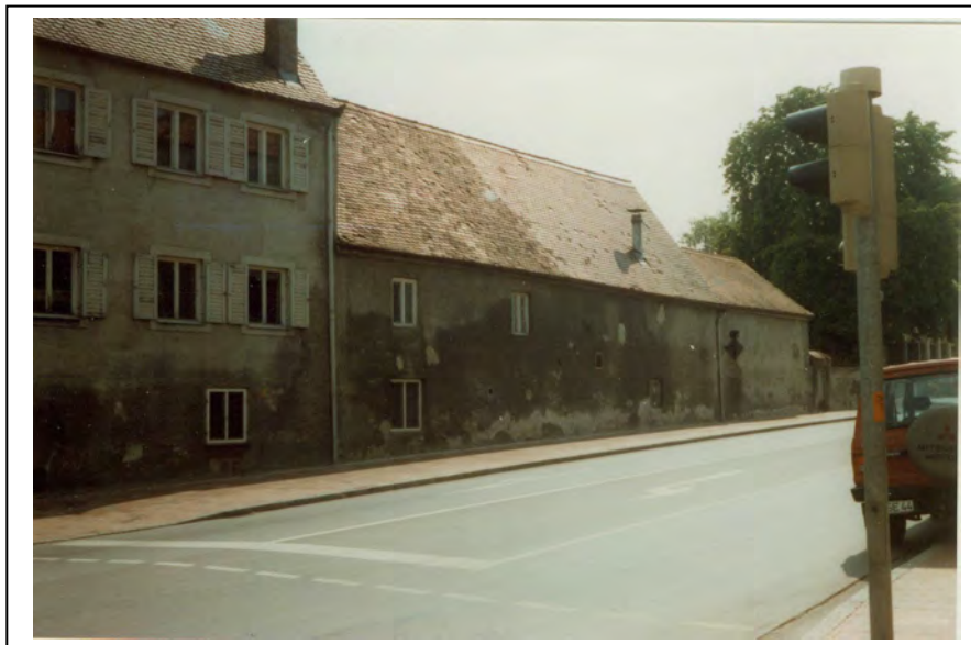
Doku-Foto Stadtbauamt vor Abbruch des Nebengebäudes 1984
