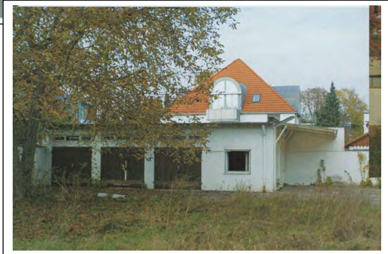
Doku-Fotos Stadtbauamt bei Abbruch 2005/2007
