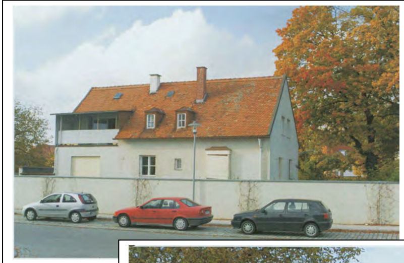
Doku-Fotos Stadtbauamt bei Abbruch 2007
