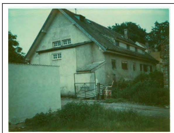
Doku-Fotos Stadtbauamt bei Abbruch 1977
