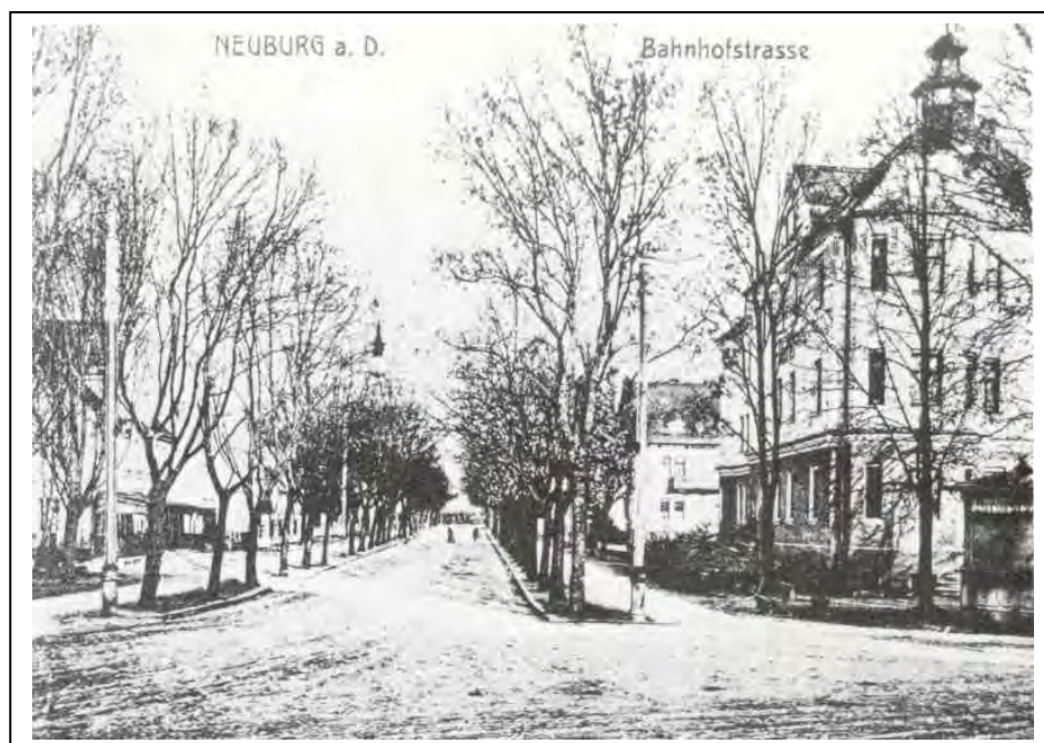
Bahnhofstraße von Süden (vom Bahnhofsgebäude) her, re. Anwesen B 138
