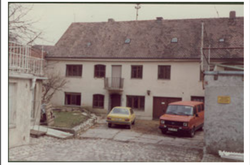
Doku-Fotos Stadtbauamt bei Abbruch Wohnhaus und Garage
